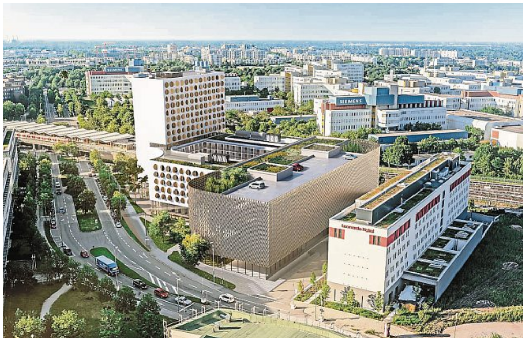
Das Projekt „R.evo Neuperlach“ umfasst ein Apartmenthaus (li.) und ein P+R-Parkhaus (Mi.). Rechts das bestehende Leonardo-Hotel.
